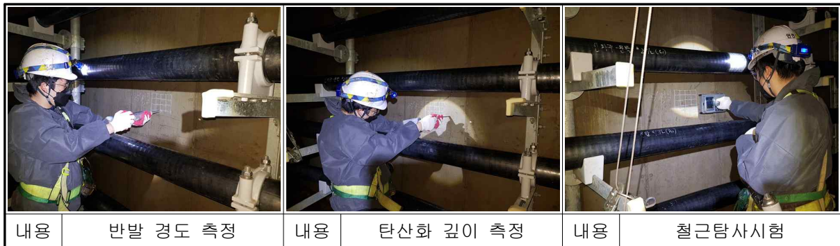
【사진 9.33】 신파주문발 재료시험 전경
